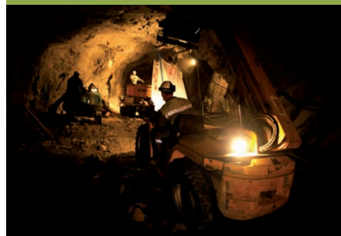
Travaux sous-glaciaire à la Mer de Glace
