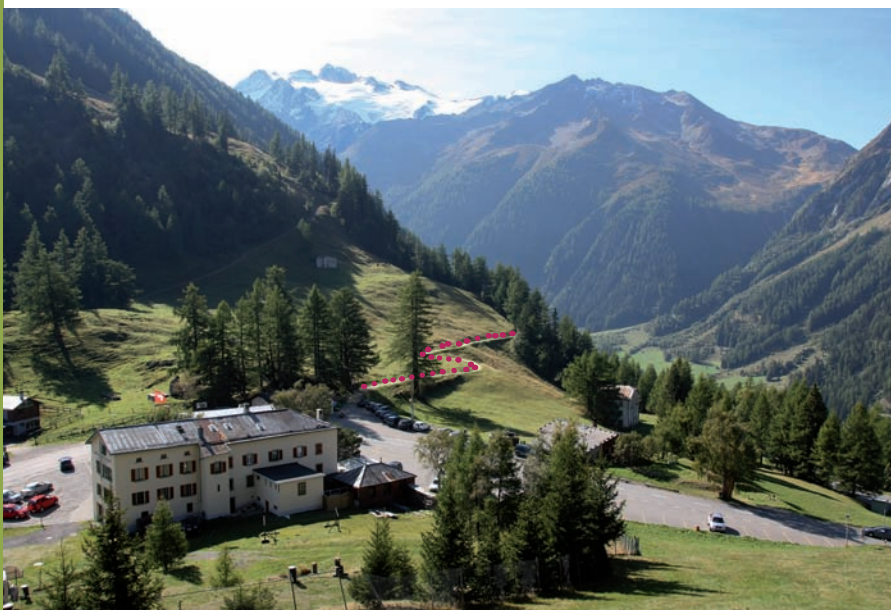
Arrivée du bisse de Trient au col de la Forclaz (Valais), longeant le sentier (pointillés rouges)
