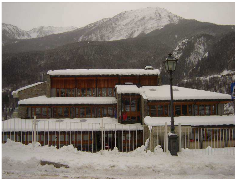
Figura 5 - Veduta della scuola primaria
