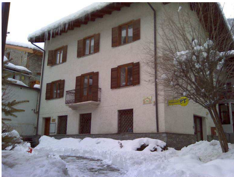
Figura 18 - Veduta del palazzo sede degli uffici postale e dell'impiego
