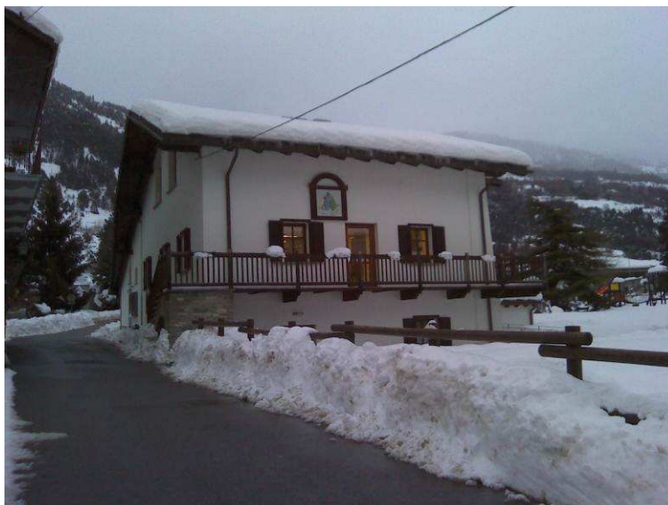
Figura 12 - Veduta della biblioteca
