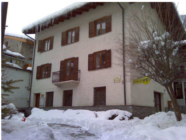
Figura 1 - Veduta del fabbricato sede dell'ufficio postale e dell'impiego
