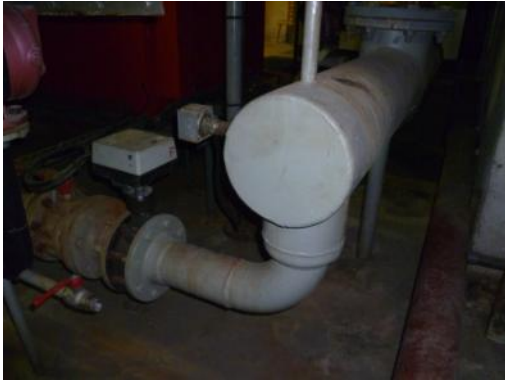
Collecteur retour non calorifugé et V3V
