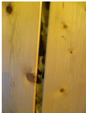
Nouveau gymnase - Isolation en laine de verre dégradée derrière bardage bois
