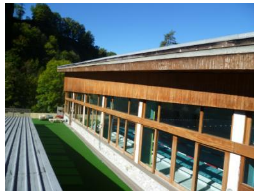
Terrasse de la piscine - paroi vitrée à menuiserie bois, vitrages ventilés par l'intérieur
