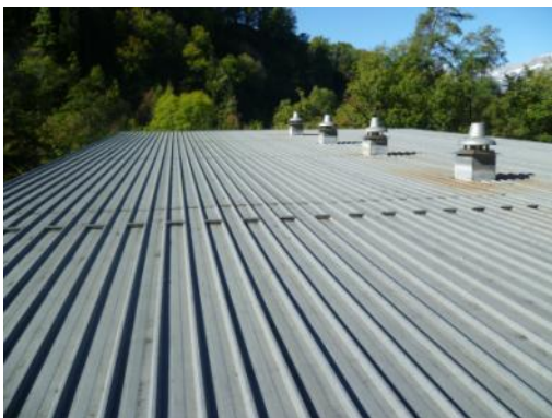
Toiture en tôle d'origine avec tourelles
