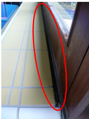
Grilles de soufflage le long des fenêtres
