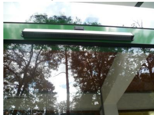
Accès vestiaires - Réglette aération sur menuiserie
