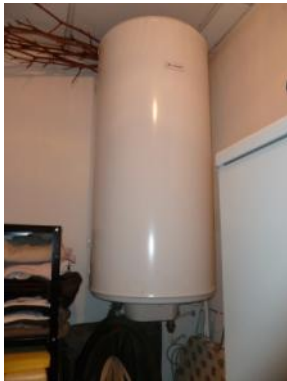
Logement - Cumulus 150 L et 2 kW
