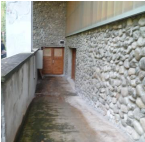
Façade Est - accès aux locaux techniques sous l'ancien gymnase
