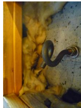
Nouveau gymnase - Isolation en laine de verre dégradée derrière bardage bois
