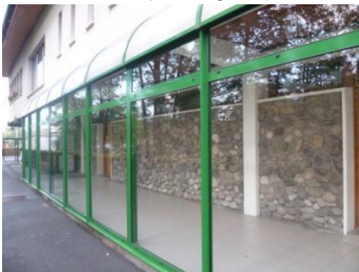
Accès vestiaires - Couloir vitré non chauffé
